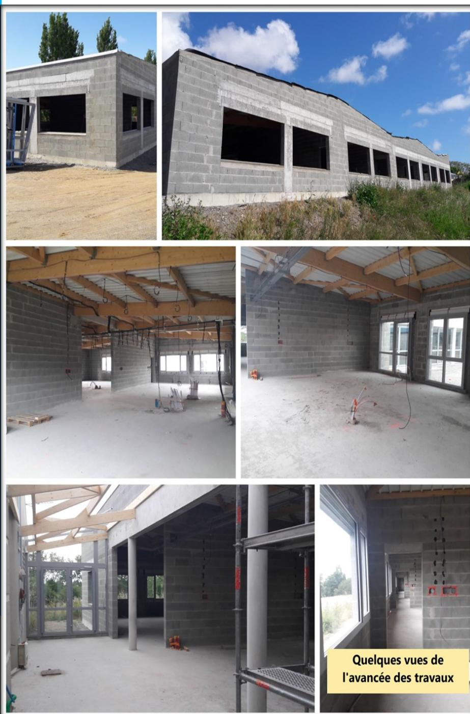
Les travaux avancent correctement avec malheureusement des retards dus à des problèmes de livraison de matériels (fenêtres, longrines métalliques) et quelques surprises lors de la démolition (canalisations percées, égouts bouchés...).
